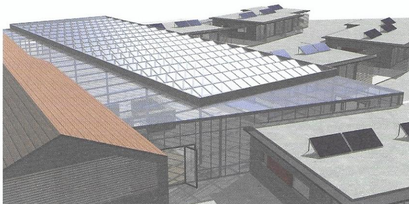
III. 8 – Lo Paratge, St-Julien-de-Lampon. La serre photovoltaïque. Document C. Pialat et A. Belingheri, architectes
