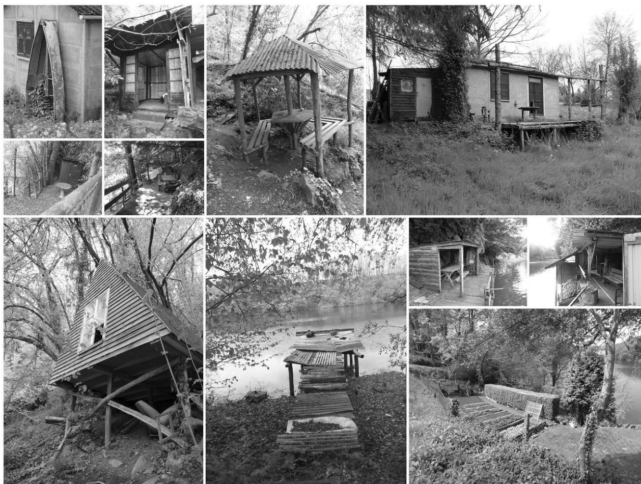
Figure 5 : Illustrations de la liberté de construction au bord de la Sélune Examples of architectural freedom in lakeside constructions
