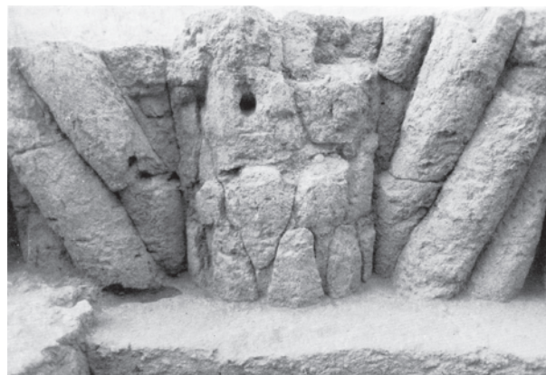
Figure 8e-f. Relief architectural. e. Tell al-Rimah, plan du Grand Temple avec ses façades à différents types de demi-colonnes (xviii e s.) (d'après OATES 1990 plan fig. 2, p. 391) ; f. Tell Leilan, façade de temple du niveau III à colonnes torses et colonne en tronc de palmier (ø env. 80 cm) (d'après WEISS 1985a, pl. 1, p. 289)
