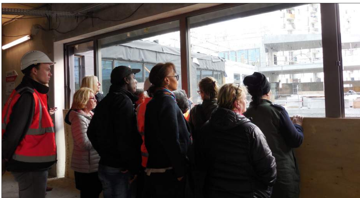
Visite de chantier par le conseil citoyen de Gagarine à Romainville
