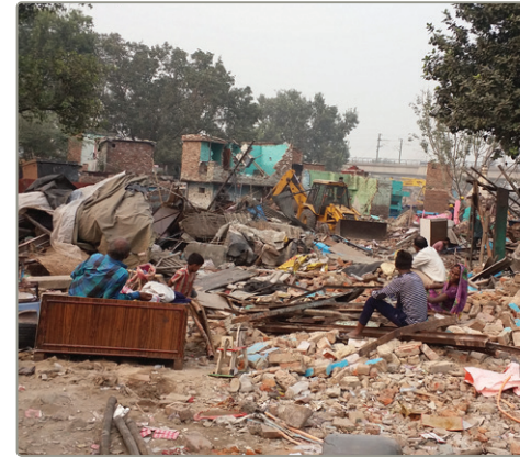
Démolition du quartier de Kathpuli Colony (2700 ménages) à Delhi (source: Shankare Gowda, 2017)
