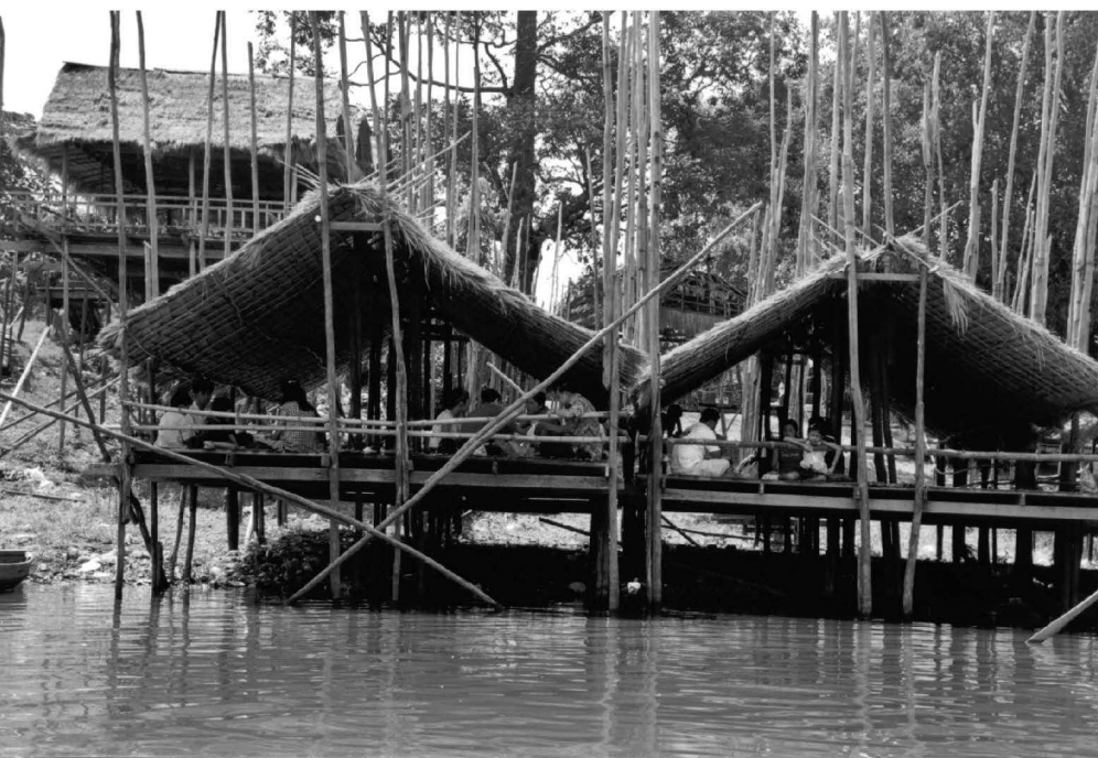
Ill. 4 : une construction précaire
