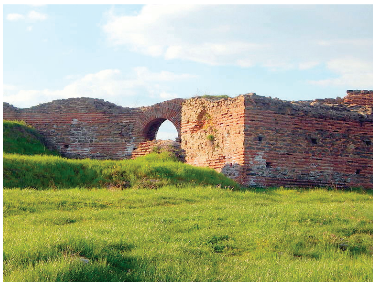
Fig. 7. Torre a sperone della porta Sud della "città alta".
