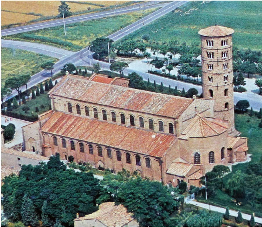
Fig. 28. Ravenne, Saint-Apollinaire in Classe : vue générale, avec le campanile du XI e siècle.
