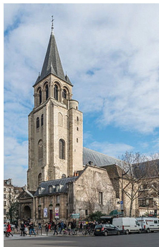
Fig. 11. Paris, Saint-Germain-des-Prés (anciennement Saint-Vincent-Sainte-Croix) : tour occidentale (surhaussée au XII e siècle).
