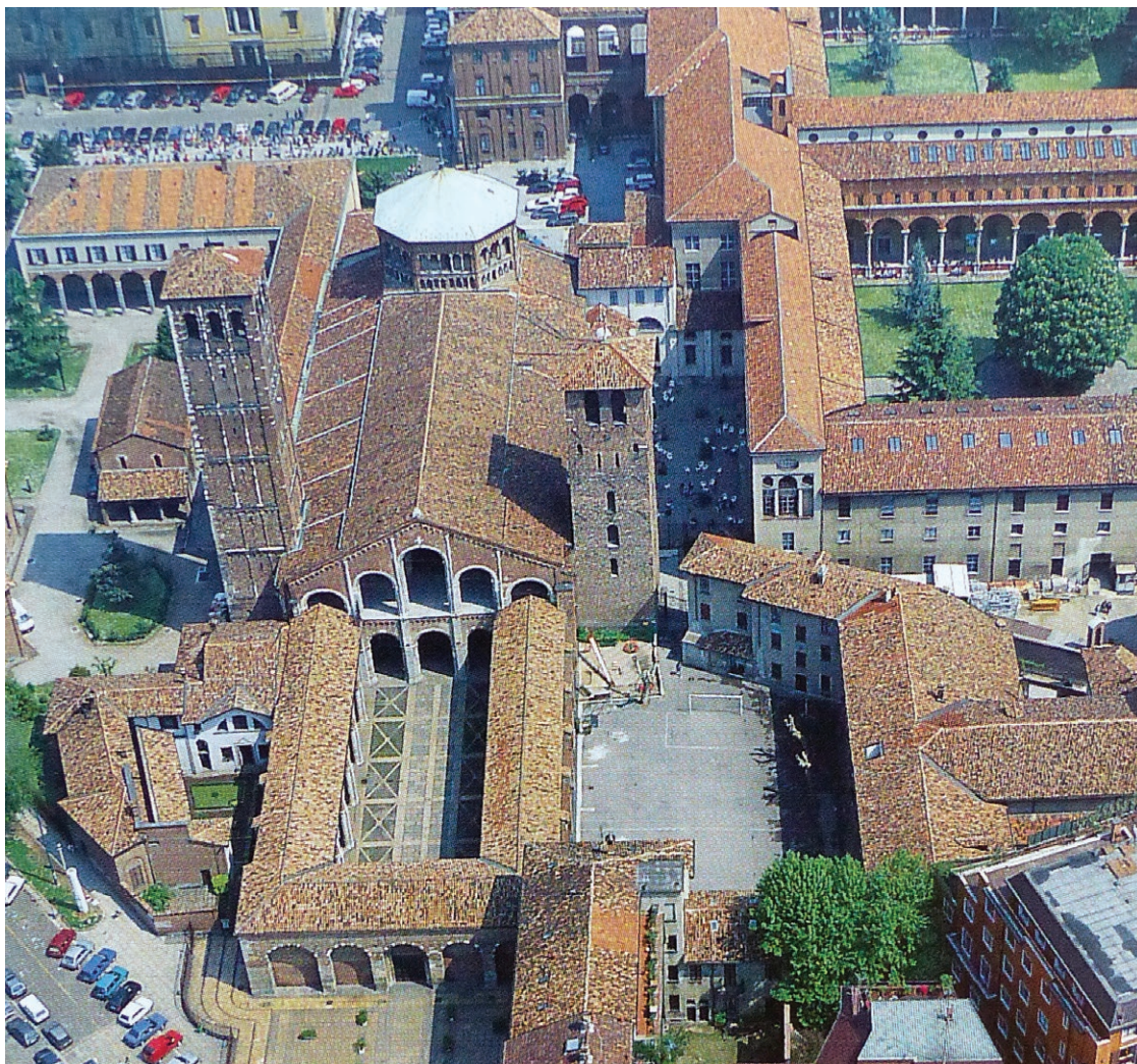
Fig. 12. Milan, Saint-Ambroise : vue générale du complexe.
