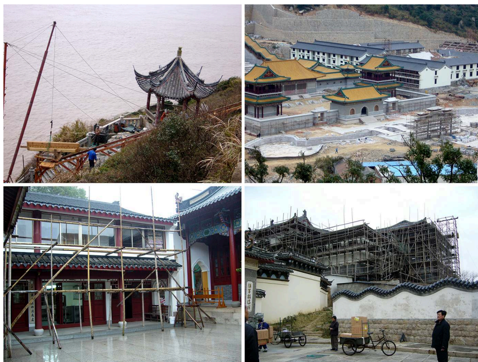
FIG. 3 – Images des chantiers en différents lieux du Putuoshan
