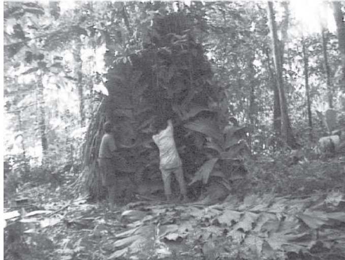
Fig. 24. Deux hommes construisent une réplique de la maison des cadavres (photo D. Jabin, 2008).
