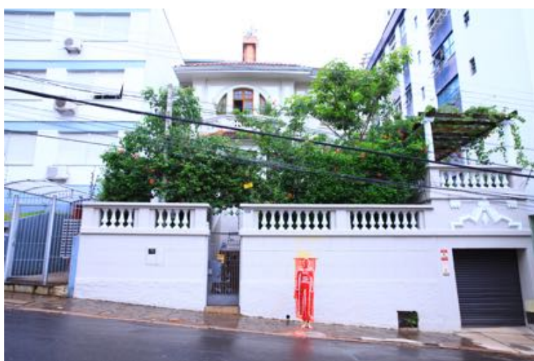
Imagem 99 – Intervenção em frente ao Dopinho, na Rua Santo Antônio, nº 600. Fonte: Foto de Pedro Isaias Lucas.
